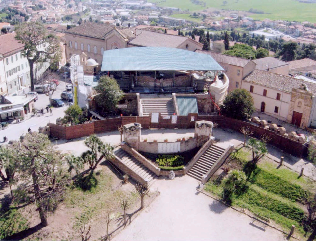
Loreto. Bastione rinascimentale di Porta Marina con tettoia e capanno abusivi.
